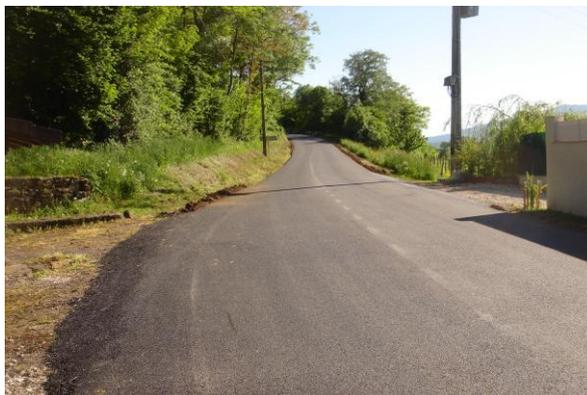
Route de Rothonod : Remise en forme du profil de la route, nouvel enrobé, renfort des bas-côtés par pose de bordures.
